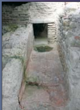
Canal de evacuación de las letrinas.
